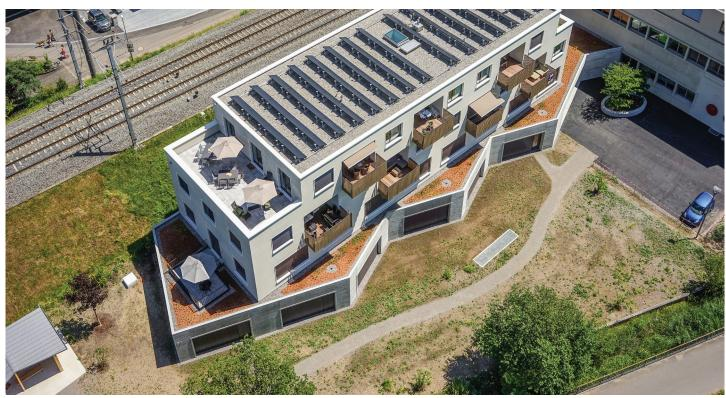
Der Eisspeicher befindet sich im Untergeschoss des Wohn- und Geschäftshauses neben der Tiefgarage. Links zwischen Gebäude und Baum ist die quadratische Einstiegsluke zu sehen, die einen Zugang für Revisionsarbeiten verschafft. Die Wärme bezieht die Liegenschaft aus dem auf dem Dach installierten Kollektorfeld. Foto: EWJR
